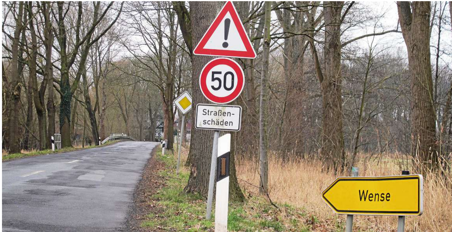
Blick auf die Wenser Allee: Seit langem wird dort der Bau eines Radweges gefordert.
